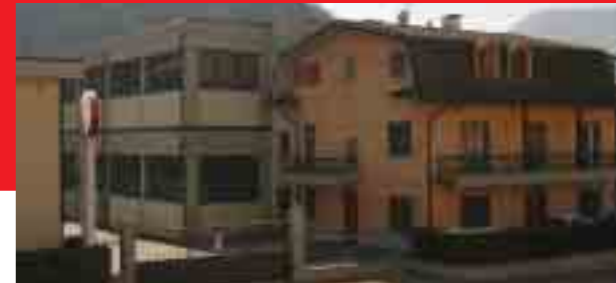
18. Stabilimento di Sarezzo 18. Building in Sarezzo
